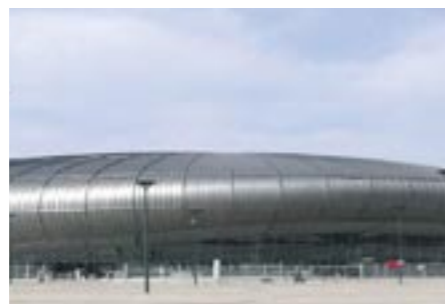
На крупных объектах Тепловых Сетей г. Будапешт (Венгрия), установлены шаровые краны Danfoss типа JIP Ду200 - 400 с ручными редукторными и электрическими приводами.
